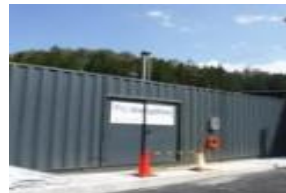
バイオマス発電施設
