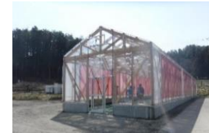
木造農業用温室栽培施設
